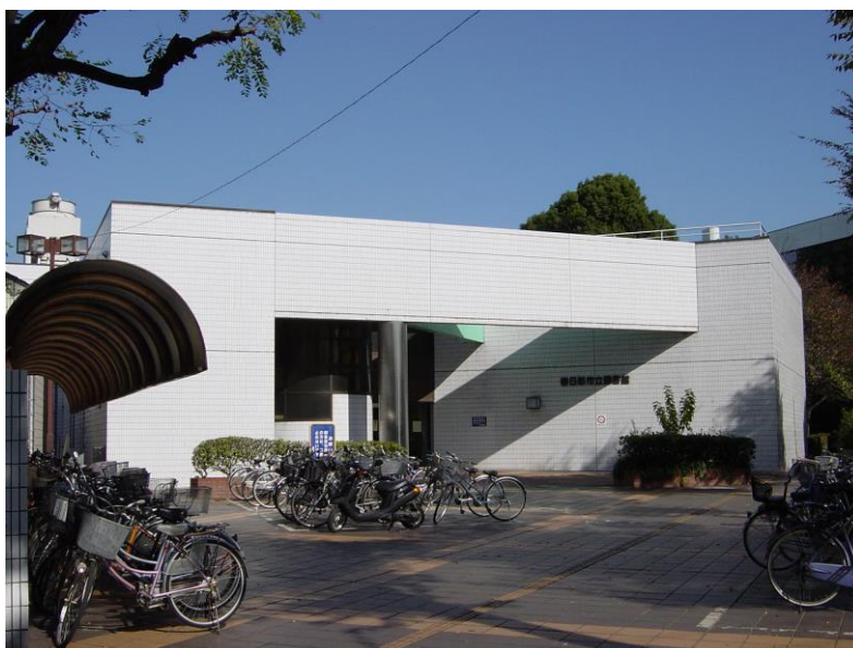
中央図書館の正面入口
